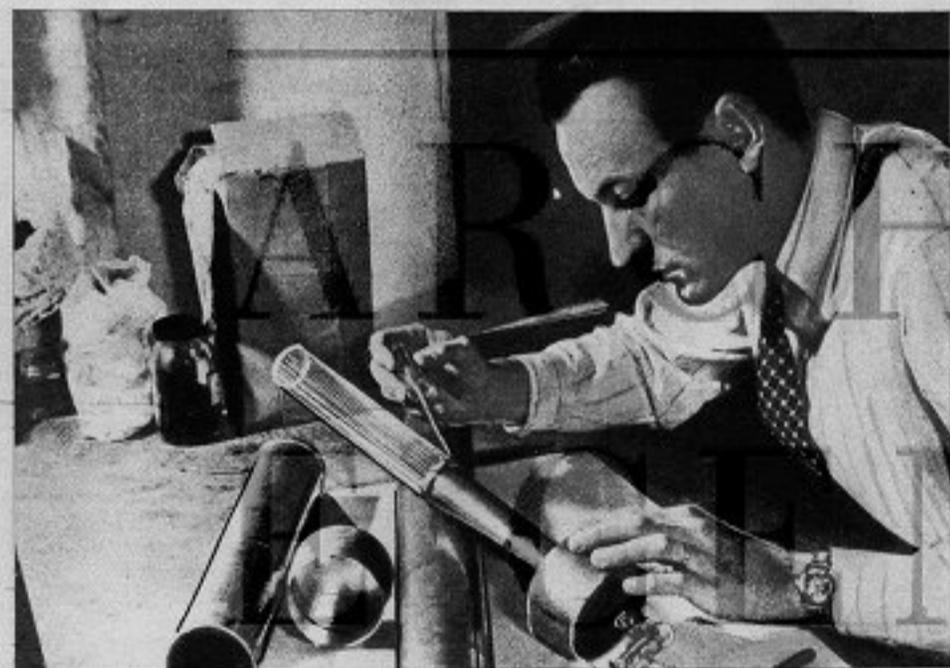
I moderni metodi di datazione mediante il carbonio-14 permettono allo scienziato di addentrarsi con maggiore sicurezza nelle profondità del più remoto passato. Nella foto: un reperto fossile introdotto in un cilindro contenente un Geiger che ne misura la radioattività e determina l'età.
