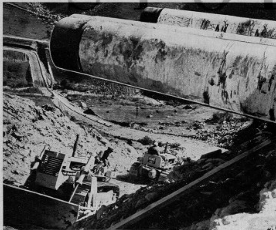
Trattori Fiat, in dotazione alla S.N.A.M., durante la posa dell'Oleodotto Centro Europa sul versante svizzero del Gran S. Bernardo.
