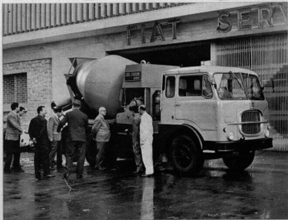
Una betoniera realizzata su autocarbinato Fiat 643 N presso gli stabilimenti Romanazzi con complessivi «Loro e Parisini». Questo particolare allestimento del 643 N, di notevole interesse tecnico, ha suscitato favorevole accoglienza nel settore edile.
