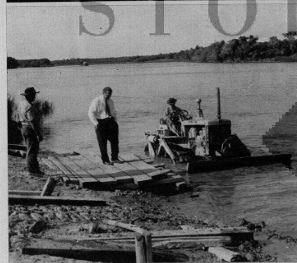
ESTADO DO PARANA' - Un trattore Fiat « 55 L » con angledoxer, appartenente alla Impresa Albino Gugelmin di São Mateus, mentre esegue lavori di dragaggio sul Rio Iguaçu. L'operazione è effettuata per evitare che la zattera in servizio sul Rio s'incagli all'approdo.
