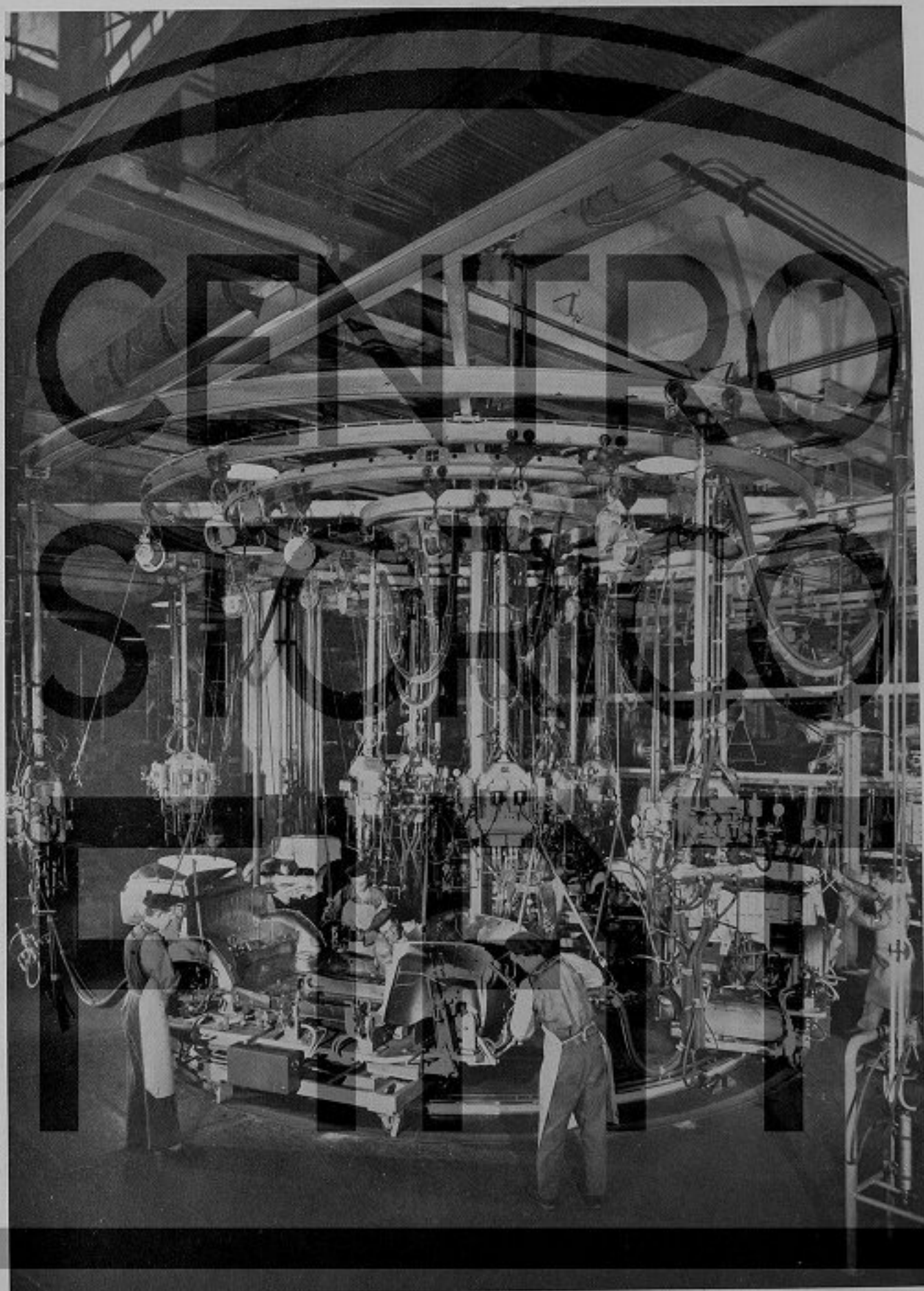
FIAT MIRAFIORI: Piattaforma rotante con unità di saldatura per il pianale della scocca dell'autovettura "600".
