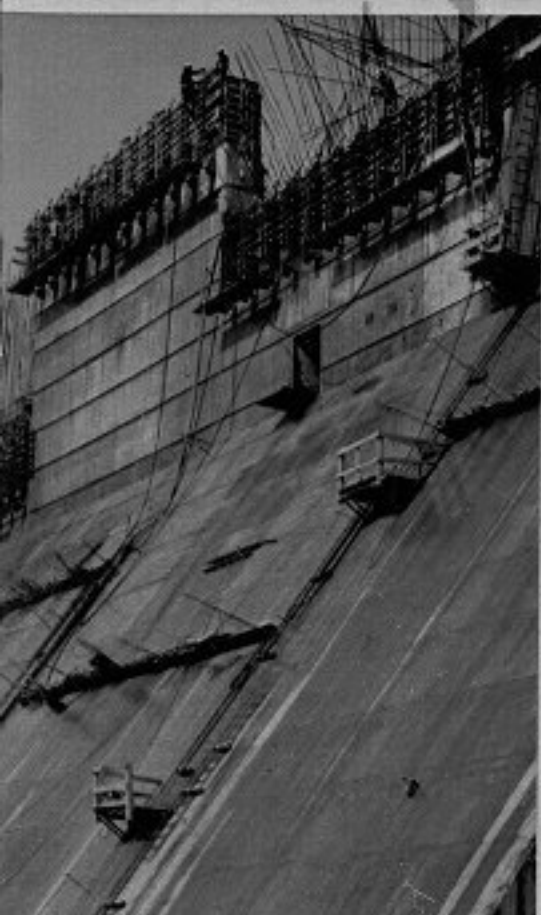
foto sotto una fase dei lavori per l'elevazione della gigantesca barriera di cemento.
