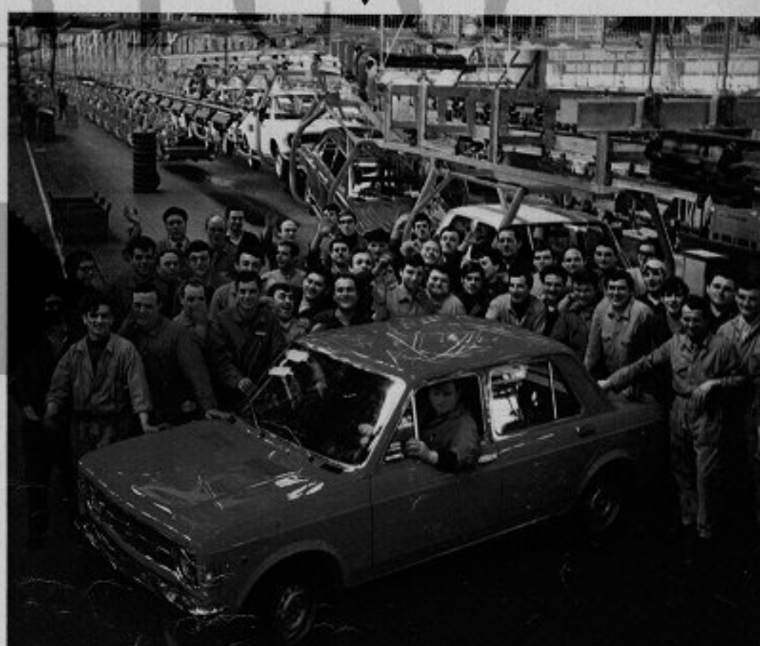
▲ Sulla linea di montaggio finale. L'inserimento dei gruppi meccanici nella scocca, a mezzo di elevatori idraulici mobili a Rivalta.
