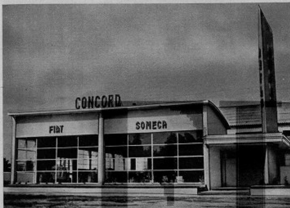
CORONEL SUAREZ (Argentina) - Nuova Stazione di Servizio «Concord» della Concessionaria «Arfa S.A.», nella Provincia di Buenos Ayres. CORONEL SUAREZ (R. Argentina) - Nueva Estación de Servicio «Concord» de la Concessionaria «Arfa S.A.», en la Provincia de Buenos Aires.
