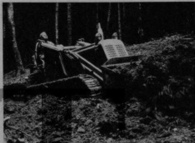
SOLEURE (Svizzera) — Questo trattore Fiat mod. 60A, con caricatore frontale, è impiegato per la costruzione di strade in foresta. La C. Industriale « Bracher und Lerdi » è molto soddisfatta del rendimento di questo mezzo.
