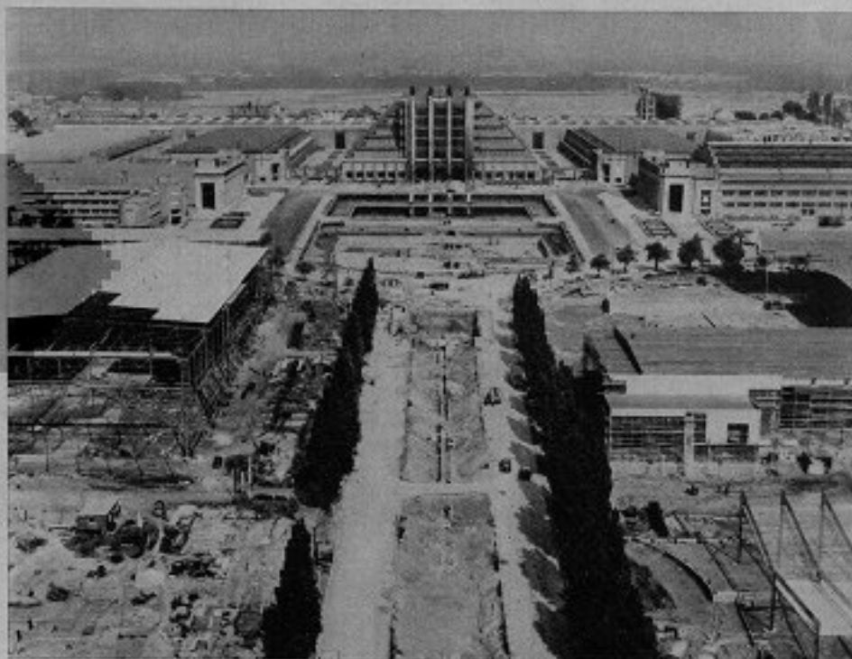
Una veduta parziale dei cantieri e dei « Grands Palais » su l'Avenue de Belgique.
