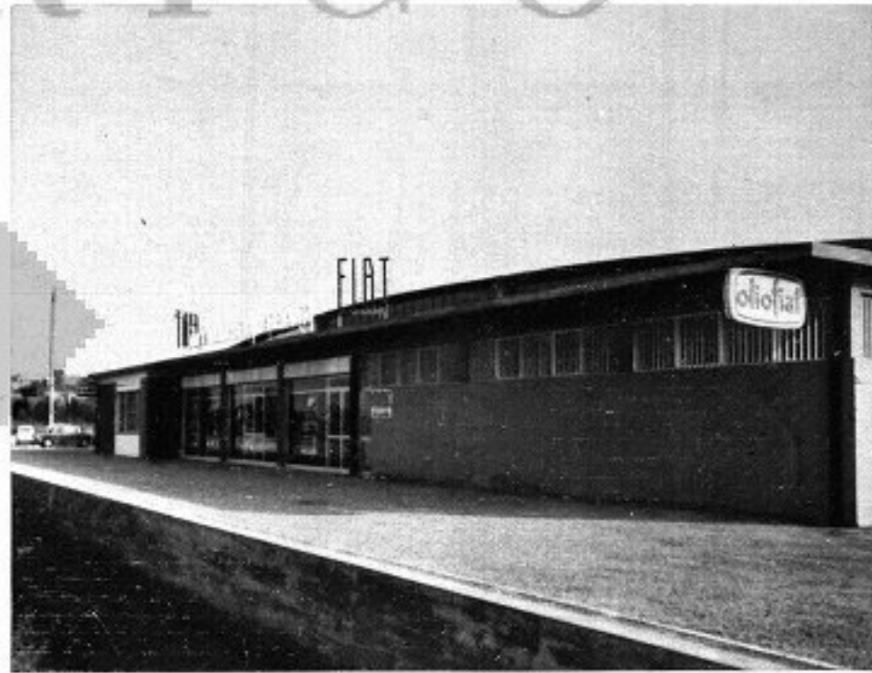
SANTARCANGELO DI ROMAGNA — La Commissionaria Fiat «Adriatico» ha aperto al pubblico la nuova sede commerciale ed assistenziale su un'area di circa 9000 m 2 , di cui 3100 di superficie coperta. Con la moderna officina ed il magazzino ricambi essa è attrezzata per tutta l'assistenza alle vetture ed ai veicoli industriali.
