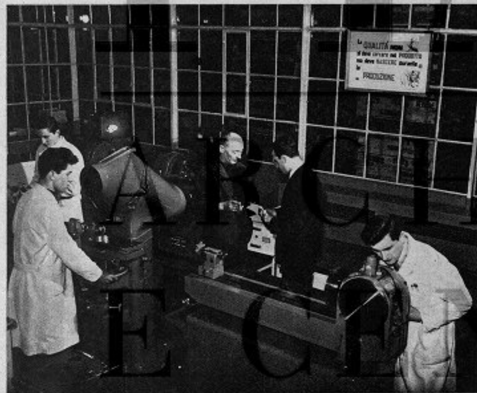
Qui siamo nel reparto controllo ingranaggi, controllo prima del loro montaggio sul cambio. Si tratta di operazioni compiute con i nuovi metodi, mediante l'impiego di aggiornatissime attrezzature ottiche ed elettroniche. Per esempio, le vibrazioni meccaniche sono analizzate con strumenti che ne traducono le caratteristiche su schermo luminoso. Nella foto, in primo piano da sinistra a destra, i giovani Elio Rocca, Federico Olumi e Domenico Gonella, ed in secondo piano il dott. Domenico Buonocore, capo della sala-controllo, mentre esamina pezzi che gli sono consegnati dall'operatore Geremia De Biasi.
