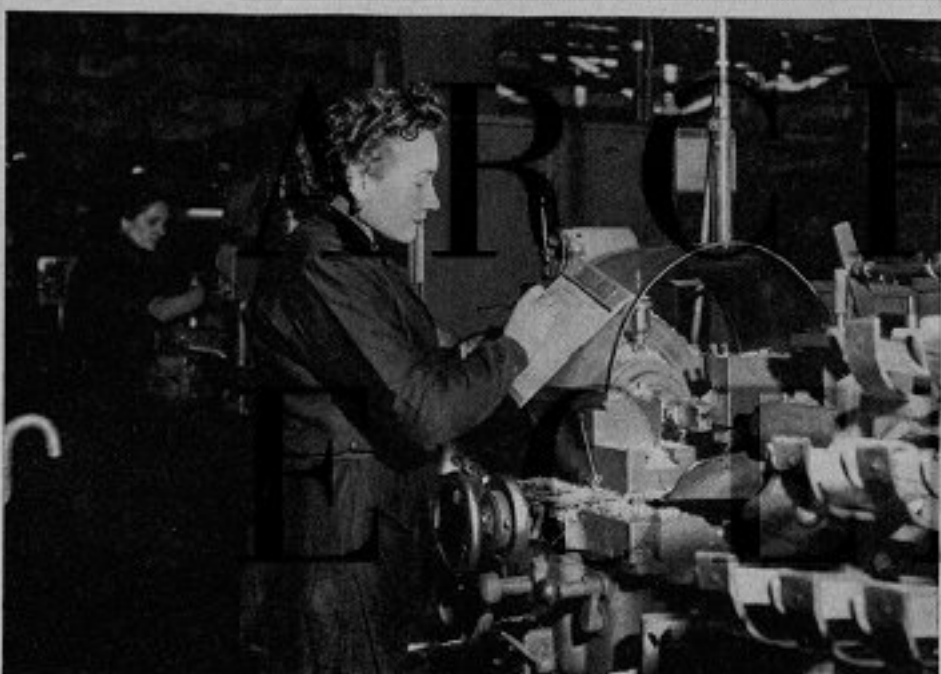
L'operatrice Maria Borgetto compie sulla scheda del «Controllo di qualità» una delle annotazioni, in virtù delle quali il processo produttivo è vigilato continuamente durante il proprio svolgimento. Questa macchina utensile è un moderno tornio, che qui compie l'alesatura per centraggio. Sullo sfondo, l'operaia Maddalena Arduino.
