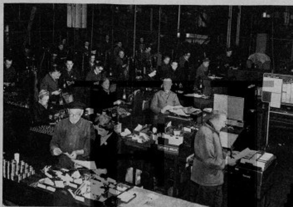
Un box del collaudo ove si eseguono perfezionati piani di campionatura. Il collaudatore, quando giungono determinati pezzi con relativa bolla di identificazione, preleva il disegno i calibri e la scheda su cui segnare le particolarità richieste. Questi accertamenti differiscono dai collaudi tradizionali anche perché si inseriscono nel ciclo della produzione in modo razionalmente tempestivo. In primo piano (con basco e occhiali) Antonio Rabozzi, 32 anni di servizio, membro del Consiglio direttivo del Gruppo Anziani Fiat, e l'impiegata Lucia Nanni. A destra, Pietro Sivera (egli pure da 32 anni alla Fiat) e Marco Alcardi.
