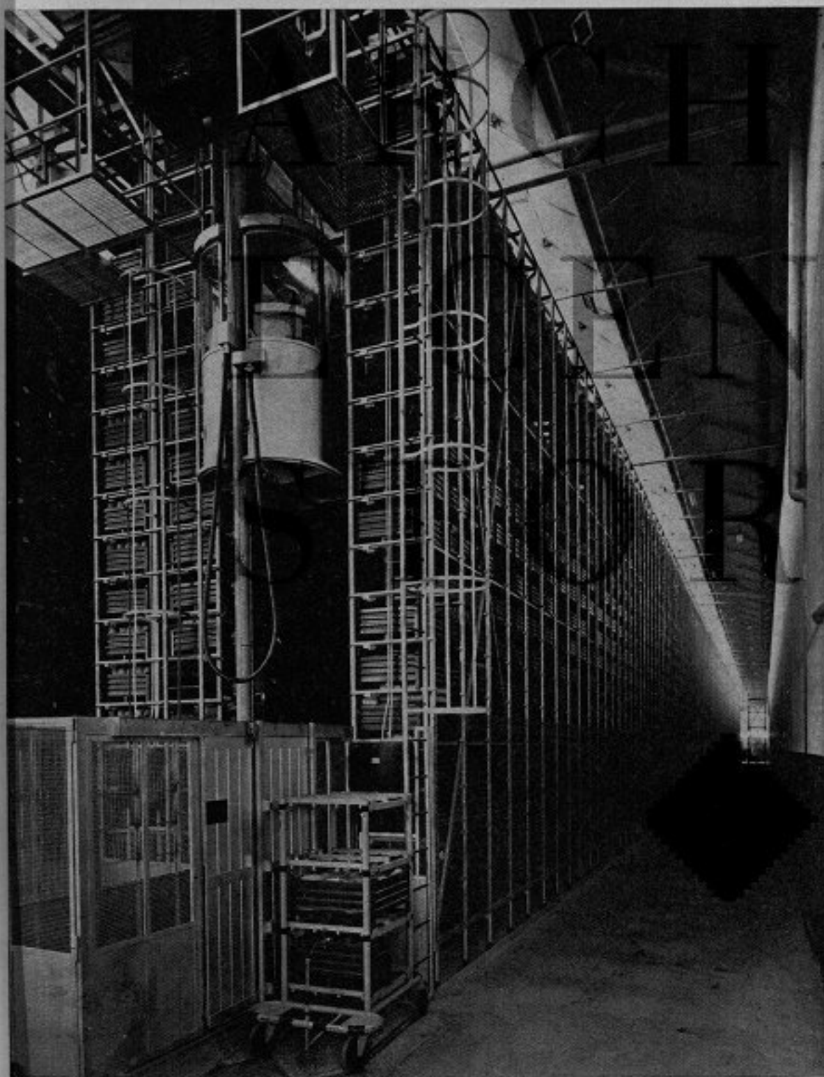
Una imponente fiancata del gruppo alti scaffali. Questi sono composti di 80.000 scomparti, con possibilità di ulteriore suddivisione, disposti su 32 facciate alte 10 metri e lunghe 106, facilmente e velocemente accessibili in ogni scomparto da 16 traslatori a cabina a doppio movimento.
