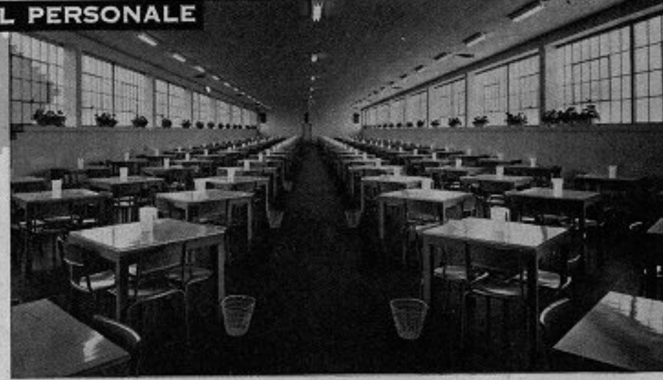
Uno dei refettori. Tutti i servizi sono dotati di impianti per l'aria condizionata.
