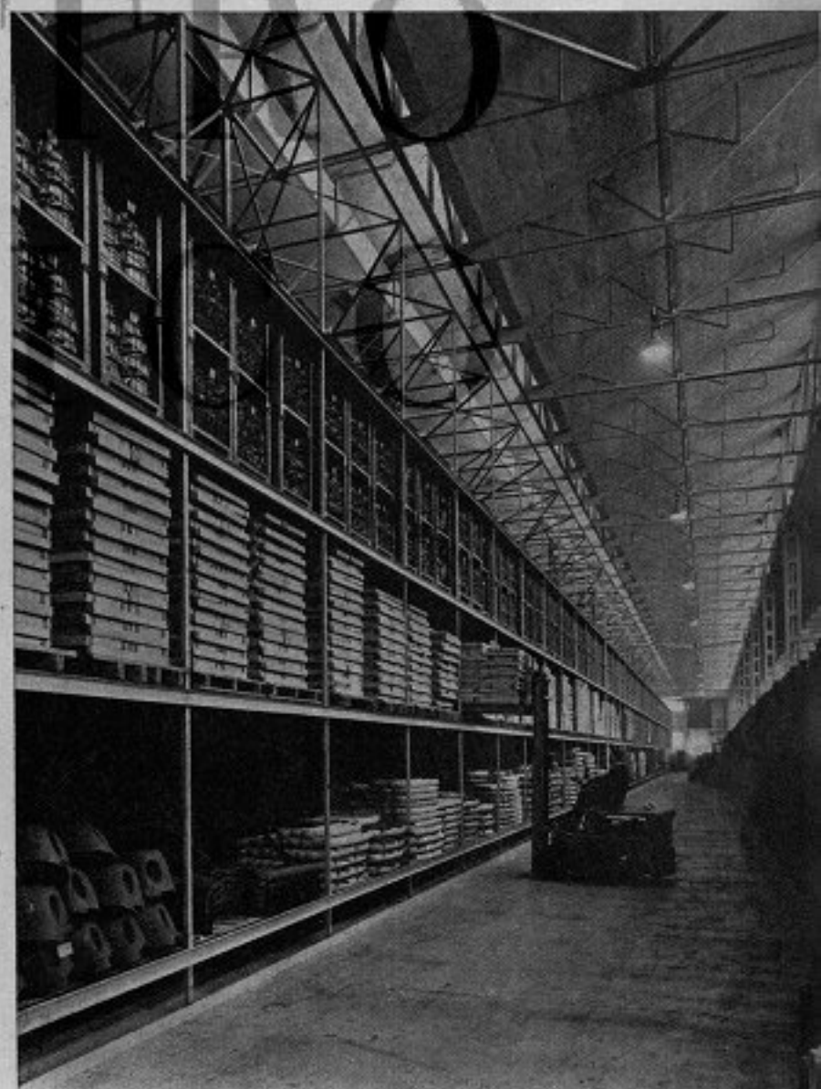
Gli scaffali per pezzi ingombranti e leggeri sono serviti da carrelli elevatori.
