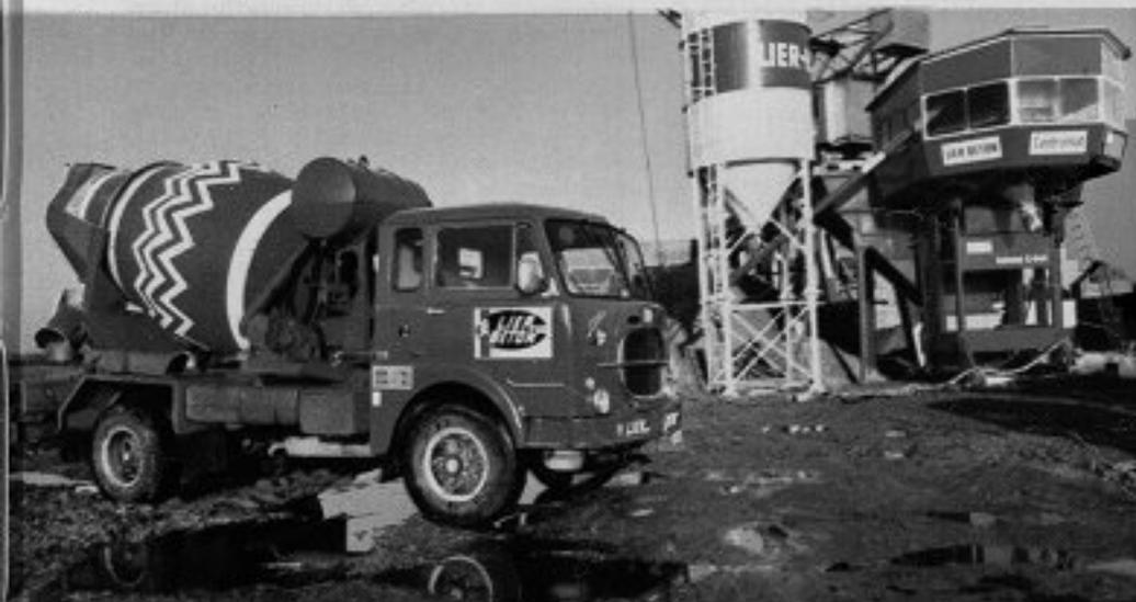
Parecchi automezzi 682 N3 sono stati forniti alla Società «Lier-Beton». Provvisi di una betoniera di 4 metri cubi di capacità, queste colorite unità svolgono numerosi servizi cantieristici nella città di Lierre e dintorni.
