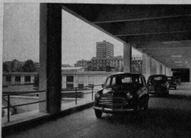
La nuova Filiale di Milano è un complesso di edifici di quattro piani: ovunque si accede in auto per rampe e passaggi coperti.
