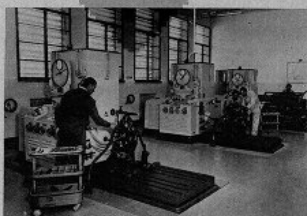
La modernità degli impianti consente di lavorare con precisione scientifica. Ecco uno dei cardini dell'ottimo servizio di assistenza: la sala prova motori. Da sinistra: Ponte Mario, Marzella Antonio (accanto, in tutta bianca, il vice capo officina Toschi Adolfo) e Cova Mario.
