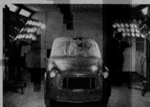
Nel reparto verniciatura, con le lampade che proiettano luce infrarossa si asciuga rapidamente la vernice. Mario Del Grande (a sinistra) e Sabrito Primo al controllo dei riflettori.
