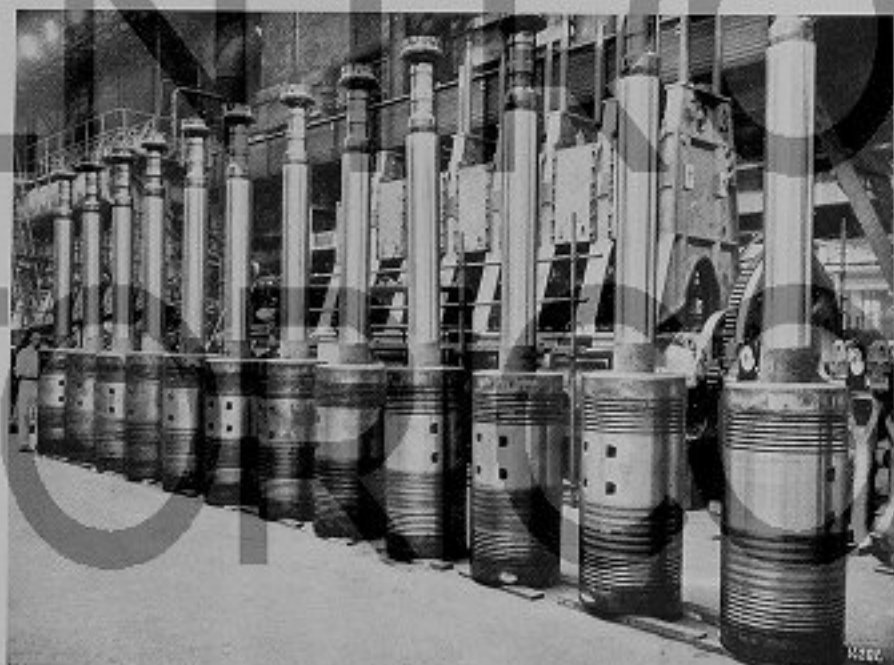
Fig. 10 - I dodici stantuffi di uno dei motori di propulsione.
