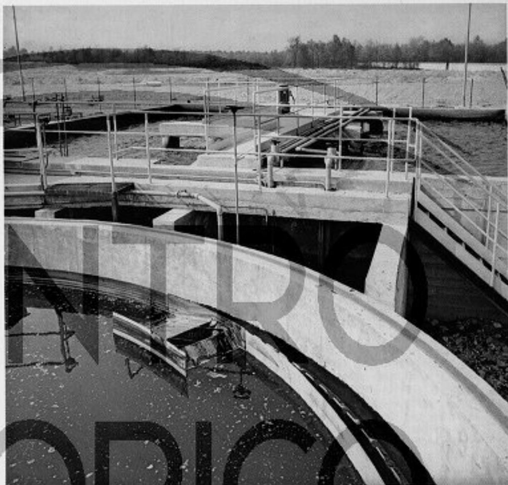
Impianto per il trattamento delle acque della rete tecnologica. Vasca di decantazione dei fanghi.
