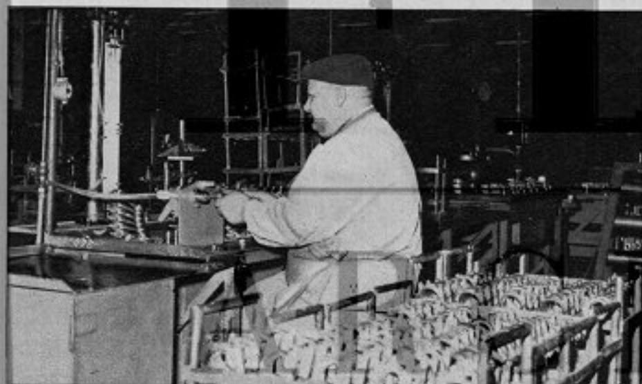
Per il rigoroso collaudo delle bielle, s'impiega uno strumento di alta sensibilità: l'apparecchio Solex, che amplificando i centesimi di millimetro, indica chiaramente su un apposito regolo le esatte misure dei pezzi da controllare. Qui vediamo al lavoro Carlo Fugazzi, cinquantaduenne.
