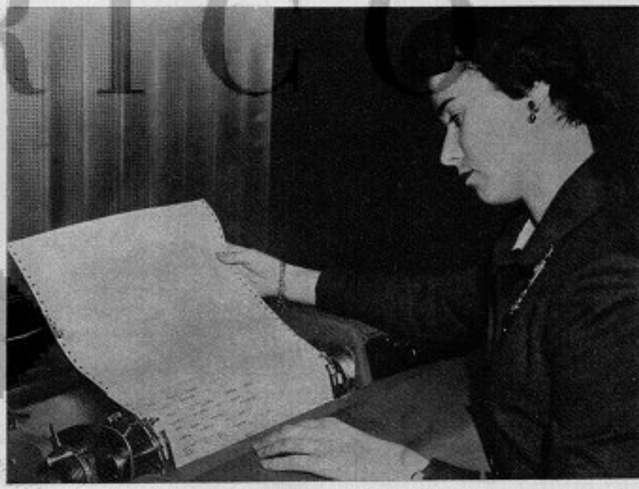
Visione della striscia di carta contenente i risultati. - La macchina che stampa i risultati esegue questa operazione esclusivamente su di un lungo rotolo di carta che è portato da un carrello molto simile a quello delle macchine per scrivere. Su questo rotolo la
