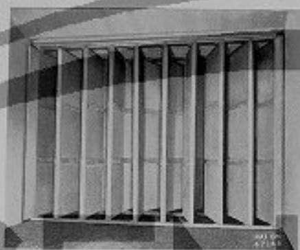
Fig. 18 - Silenziatore di aspirazione per turbina a gas FIAT TG 3000 della Centrale di Chivasso. Vista lato ingresso aria
