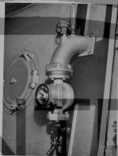
Fig. 16 - Controllo raffreddamento stantuffi
