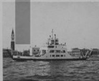
In copertina: La Min traghetto "Ambrone", recentemente messa in servizio dall'A.C.N.F.L. per il trasporto delle vetture al Lido di Venezia. L'apparato di propulsione è costituito da 2 motori FIAT a 4 tempi tipo L 236 S
