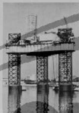
In copertina: La piattaforma mobile per ricerche petrolifere "Gatto Selvatico", dell'AGIP MINERARIA, che costituisce la prima piattaforma mobile autosufficiente realizzata in Italia, dotata di sei motori FIAT 230 ESS.
