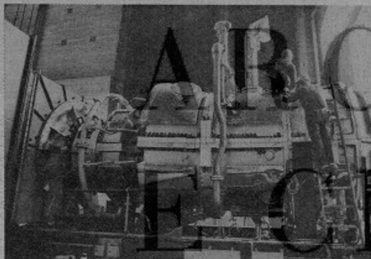
I tecnici della Fiat Aviazione montano la nuova turbina della centrale di Mirafiori. In alto: il camino alto 60 metri
