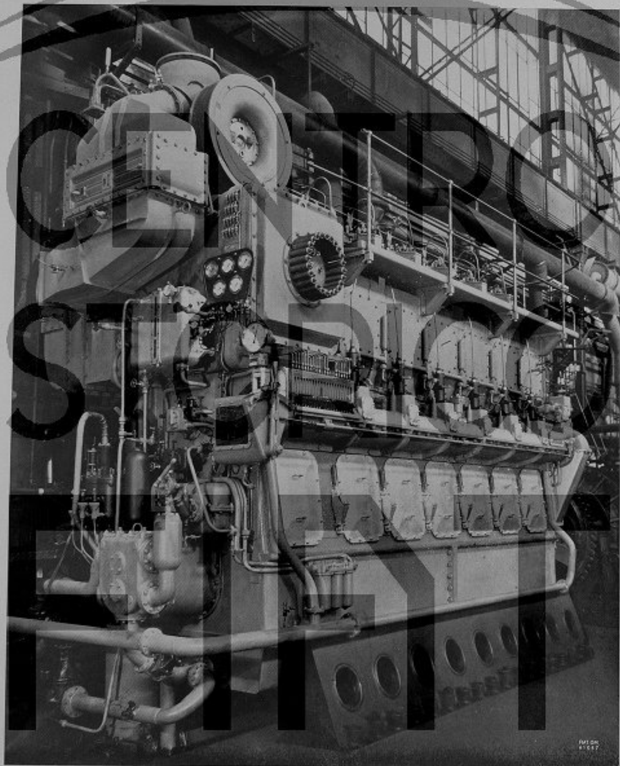
Motore FIAT tipo B 366 S: esecuzione con turbosoffiante sul motore.
