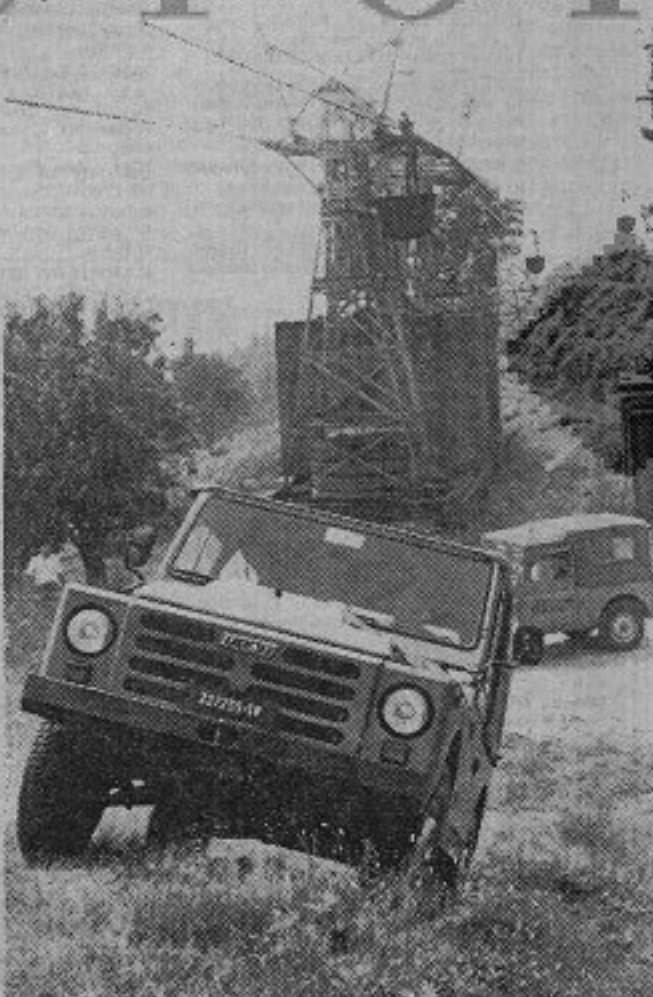
Al lavoro su un difficile tratto della funivia Savona-S. Giuseppe
