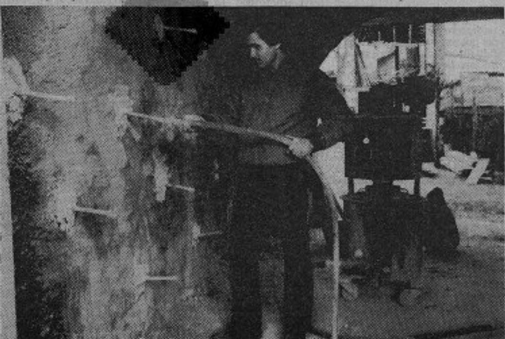
Le iniezioni di cemento liquido, una delle tecniche per rinforzare i vecchi muri di pietra
