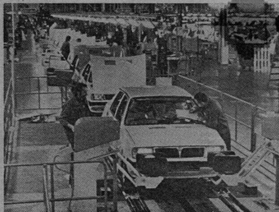
Dopo che tutti i particolari hanno trovato la loro giusta collocazione, inizia una lunga serie di controlli e collaudi. Nella foto la prova assetto furi, l'ultima della linea
