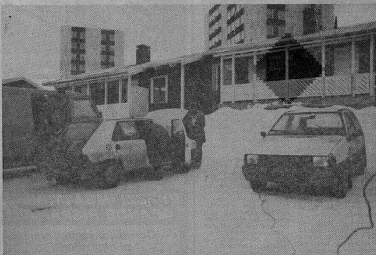
Alcune fasi del severo collaudo a 40° sottozero cui è stata sottoposta in Svezia la Uno, camuffata da «Panda»
