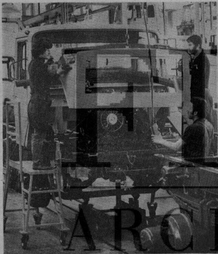
Fase di assemblaggio cabine e cofani motore degli autocarri Magirus
