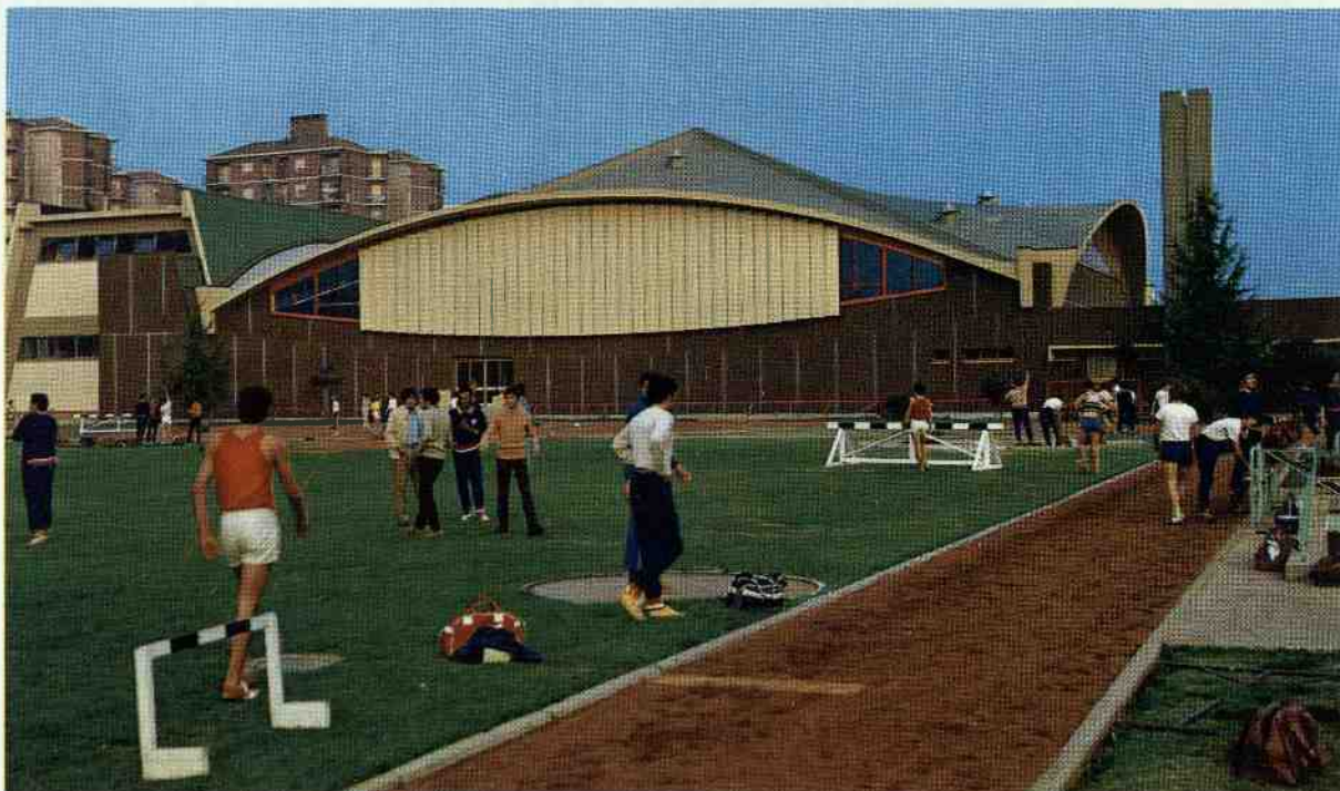
Campo sportivo G. Agnelli. Nuova palestra coperta (vista dall'esterno e dall'interno).
