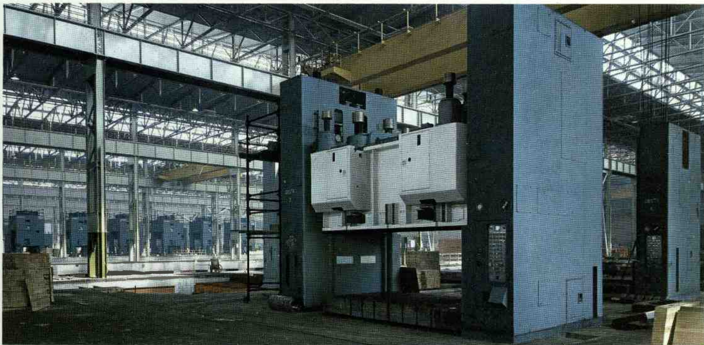
Sezione Officine di Rivalta. Centro Presse in allestimento.
