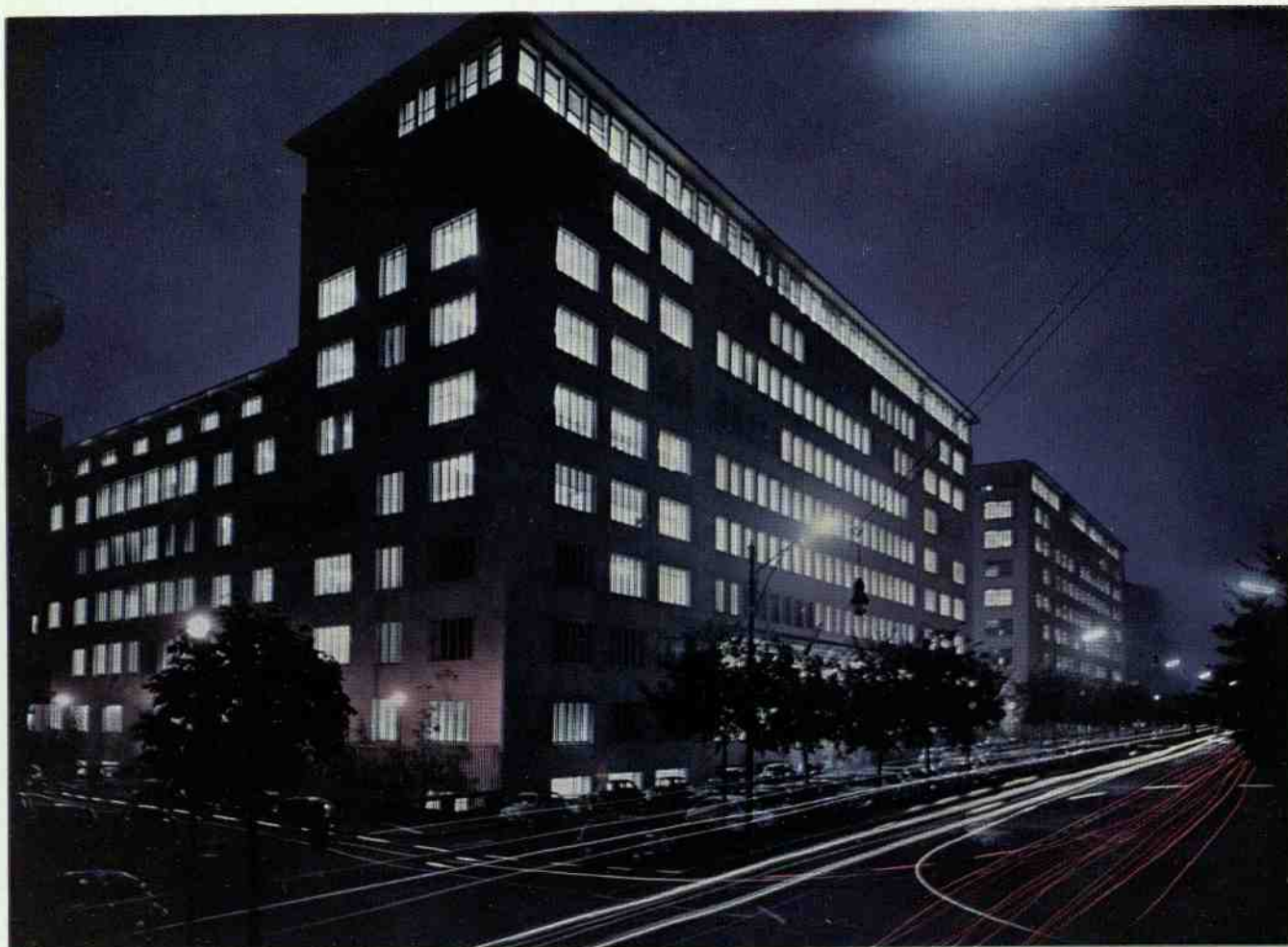
La Sede centrale della Fiat in Corso Marconi.
