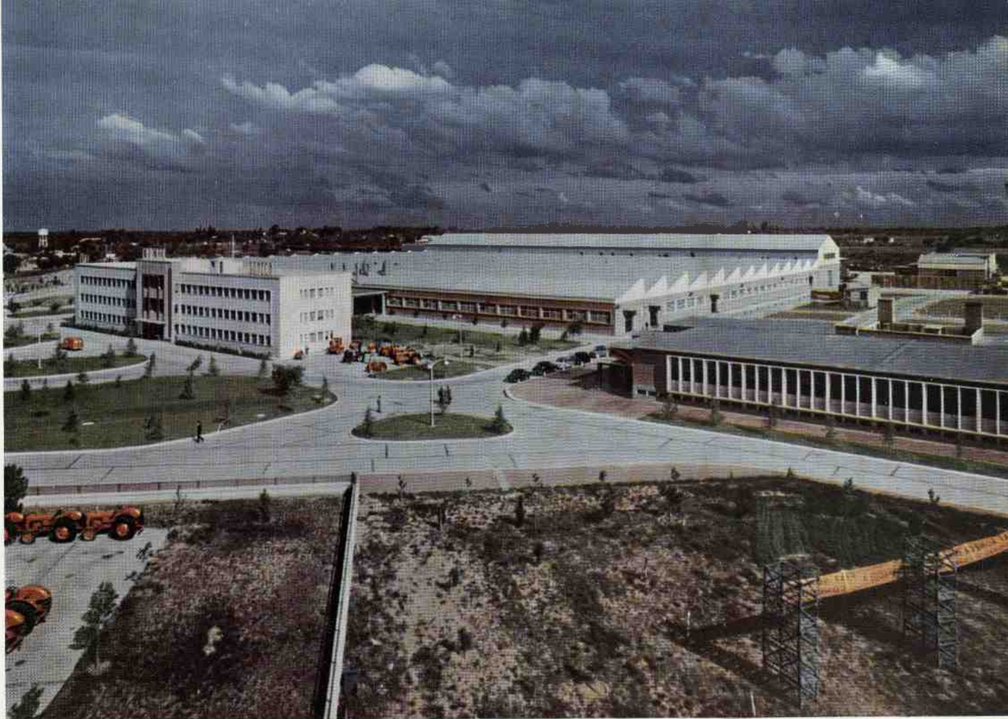
Cordoba (Argentina) - Veduta esterna dello stabilimento "Concord" per la costruzione in Argentina di trattori su licenza Fiat e Someca.
