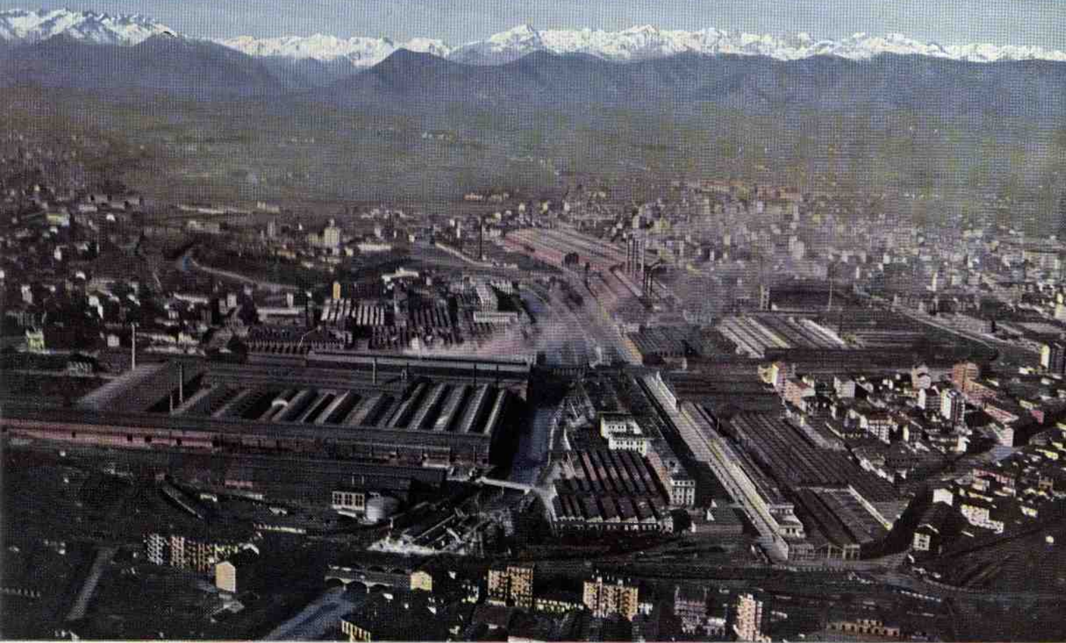
Veduta aerea del complesso siderurgico Fiat Ferriere.
