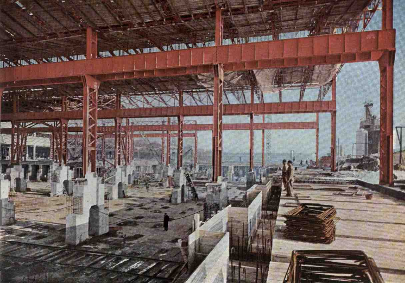
Mirafiori Sud - Una inquadratura dello stabilimento in costruzione, con in primo piano gli importanti lavori realizzati per le fondazioni delle presse.
