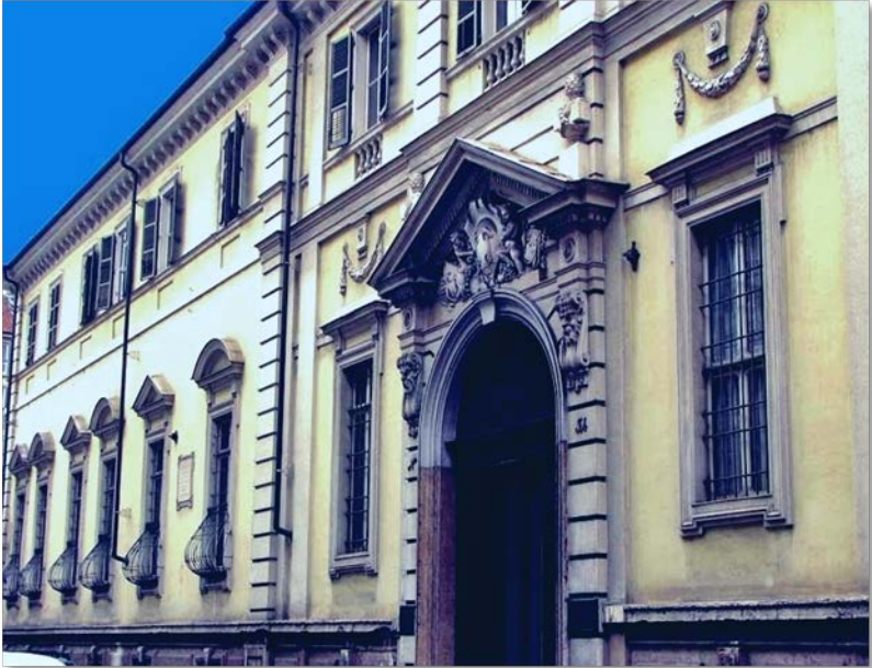
Main entrance of Palazzo d'Azeglio
