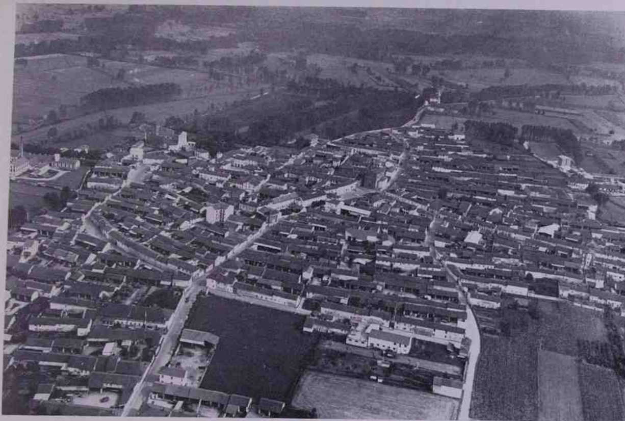
Fig. 6 Caramgnolo: Piemonte - Il vecchio borgo denuncia, nelle costruzioni in linea, a fasce parallele intervallate da corti e vie, l'origine contadina. In alto, a sinistra, tra la piazza e la grande chiesa parrocchiale, è il nucleo più antico, costruito su una crociera di due vie ortogonali. Un esempio tra tanti di agglomerato fortemente tipizzato in corso di trasformazione a causa dei fenomeni di industrializzazione indotti dalla grande città: ne sono conferma casi, per ora sporadici, di condomini che già brutalizzano l'originaria struttura.
