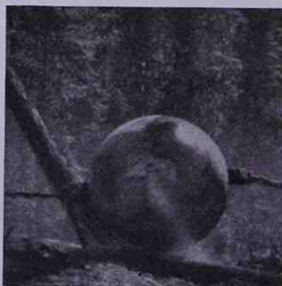
L'abbattimento operato mediante sfera di acciaio trainata.
