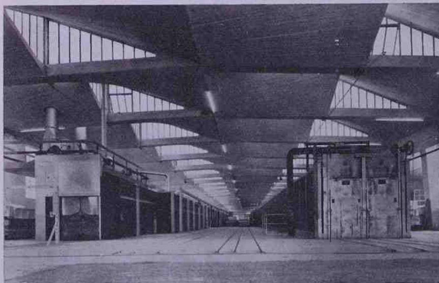
Ing. Felice Bertone: capannone a shed multiplo con volte sghembe.
