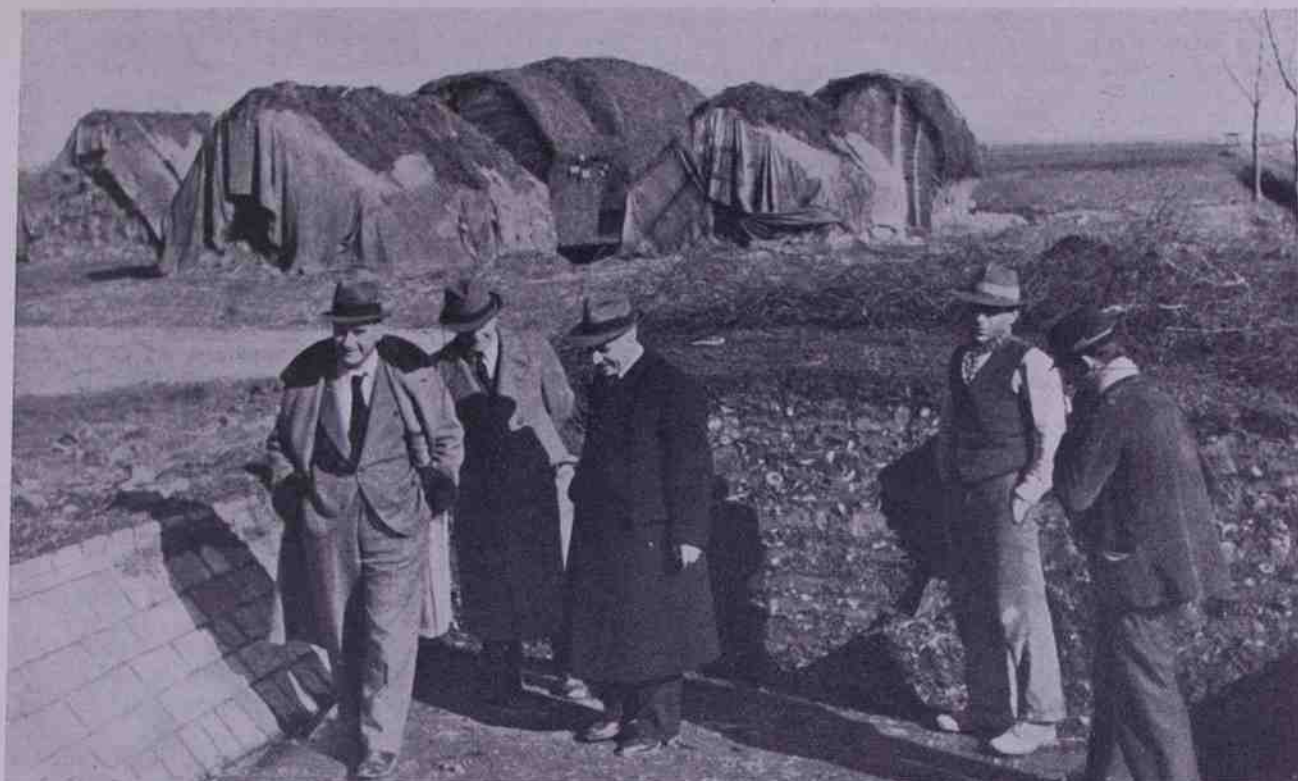
Cumuli di fieno nel Ravennate coperti da teloni per ripararlo dalle intemperie.
