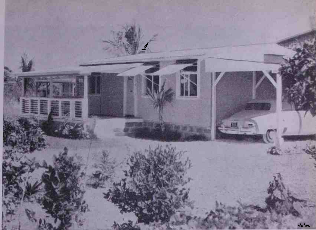
Villino prefabbricato con pannelli di alluminio; 162 di questi villini a tipo tropicale sono stati costruiti in Gran Bretagna per il Governo australiano. Perfettamente completi in ogni piccolo dettaglio, questi villini hanno una veranda con porticato che permette di dormire all'aria aperta.
