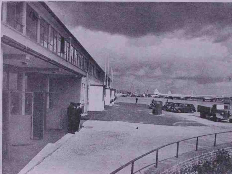
Fig. 9 — L'ingresso del nuovo edificio passeggeri dell'aeroporto di Londra costruito in elementi di calcestruzzo prefabbricati a tempo di primato
