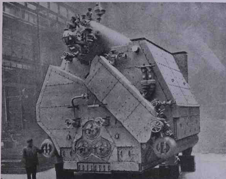
Caldaia marina a 3 collettori a surriscaldatori Me Le Sco.
