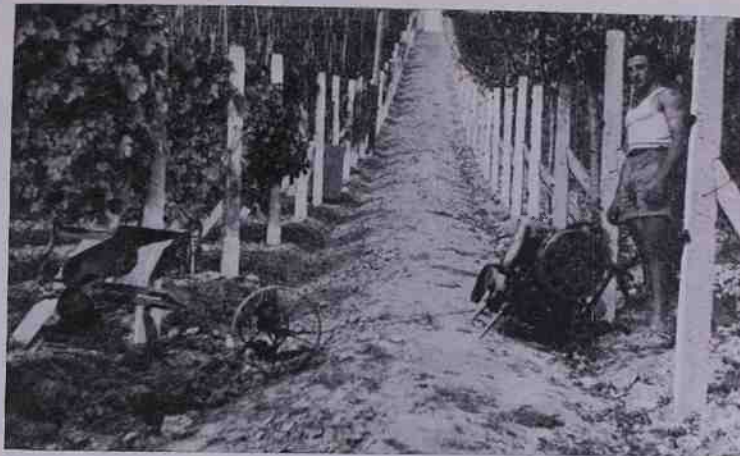
Fig. 5 — L'aratro è giunto alla fine della sua corsa: a destra uno dei due moto-argani ancorato al suolo
