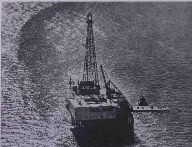
Un'isola d'acciaio sulle acque del Golfo del Messico. Trattasi della base da cui vengono effettuate le perforazioni per trarre il petrolio dai giacimenti sottomarini. Sull'isola trovano posto oltre che gli impianti petroliferi, gli alloggi per le squadre, i magazzini, i depositi di materiali, ecc.
