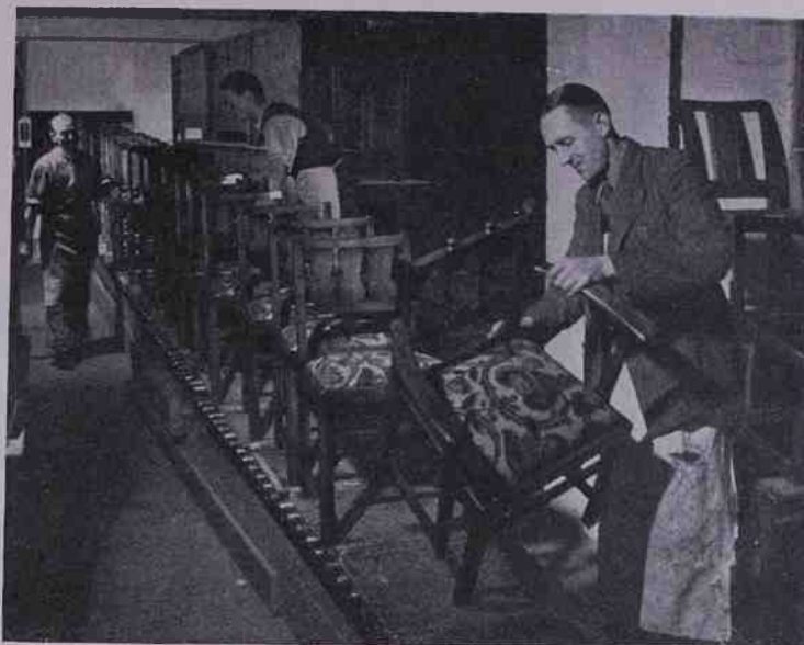
Ultima fase del montaggio di una sedia per camera da pranzo (lavorazione di una piccola industria).
