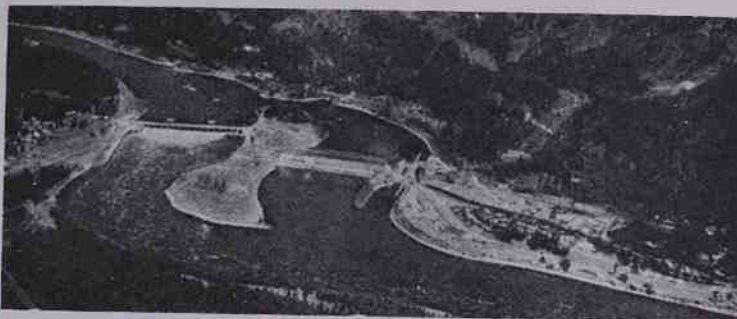
Fig. 1. — Impianto idroelettrico sul fiume Colombia con turbine Kaplan fra le più potenti che siano state costruite: potenza 74.000 HP, salto 20 metri, velocità di rotazione 75 giri/min. Queste turbine hanno dimensioni eccezionali: diametro della girante oltre 8 m.; ogni unità pesa 900 tonni
