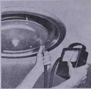
Fig. 3. — Diffusore per impianti di condizionamento dell'aria e ventilazione ambienti. Lo strumento determina la portata d'aria (W. B. Conrner Engineering Corp.).
