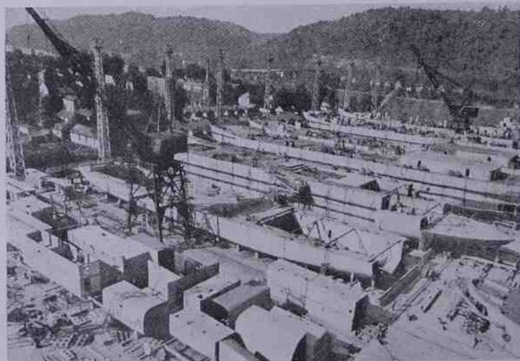
Fig. 11. — Il cantiere navale Ovest della Dravo a Neville Island: le navi costruite in elementi prefabbricati vengono montate ed avanzano verso l'acqua con il progredire del loro montaggio (Dravo Corporation).
