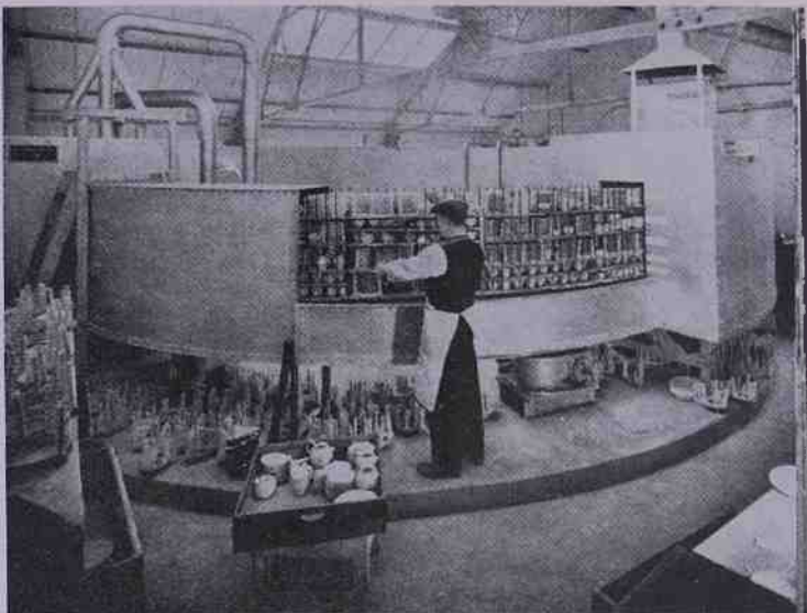
Fig. B) — Forno a tunnel circolare per ceramica. (Gibbons Bros. Ltd. & G. W. B. Electric Furnaces Ltd.).
