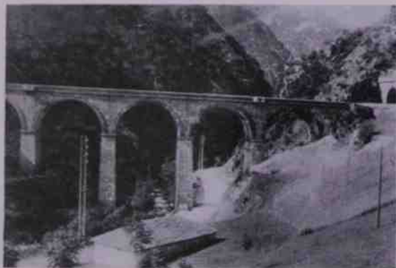
Viadotto sul fiume Roja e imbocco Cuneo della galleria Gaggeo (distretto)
