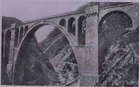
Il ponte di Scarassou (distrutto).
