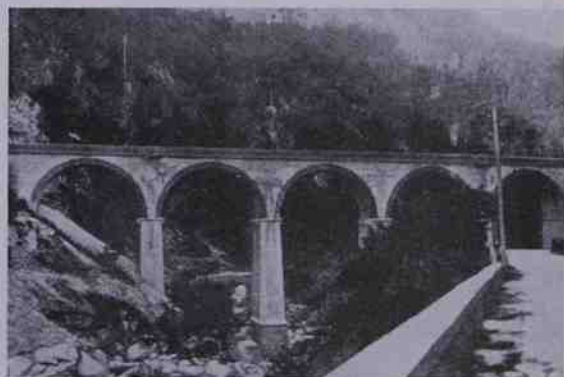
Viadotto sul fiume Roja (danneggiato).
