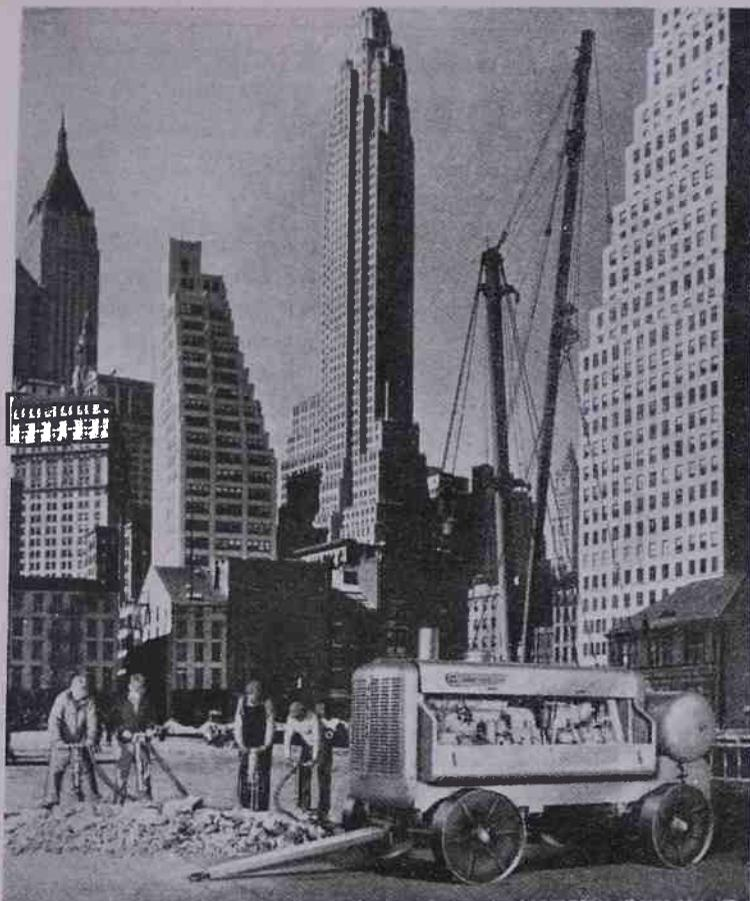
**Fig. 2. - Un gruppo moto compressore a combustione interna per il comando di martelli pneumatici usati nelle riparazioni di strade.**
