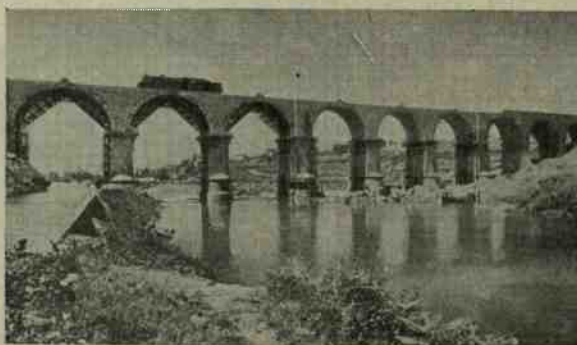
11. Collaudo del nuovo ponte sull'Oglio a Palazzolo (linea Brescia - Bergamo)
