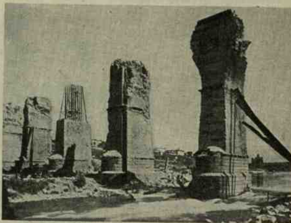
10. I resti del ponte sull'Oglio a Palazzolo (linea Brescia - Bergamo)
