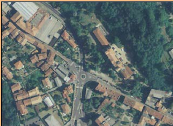
FIG. 9.23 L'INCROCIO TRA LA SP 100 E LA SP 110 NEL COMUNE DI SAGLIANO MICCA INTERESSATO DALL'INTERVENTO
