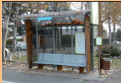
FIG. 9.10 GOZZANO: UNA DELLE FERMATE DEL TRASPORTO PUBBLICO MESSA IN SICUREZZA
