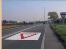
FIG. 9.8 ESEMPI DI INSTALLAZIONE DI NUOVA SEGNALETICA ORIZZONTALE
