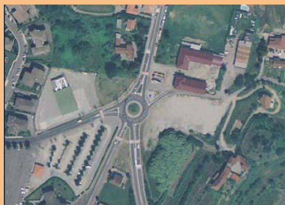
FIG. 9.22 IL TRATTO DELLA SP EX SR 143 NEL COMUNE DI CERRIONE INTERESSATO DALL'INTERVENTO
