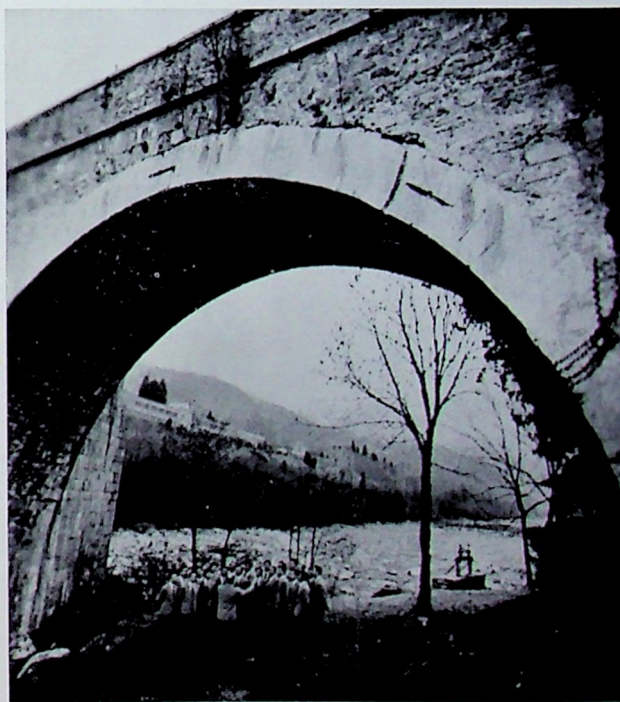
Sotto l'arco del ponte napoleonico di Agnona, mentre sul fondale si prospetta la sagoma dello stabilimento, i « Cantores Mundi » provano le armonie antiche che superano i tempi
