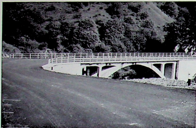
Un ponte, nello svolgersi del tracciato, è un elemento che propone un diversivo a ricordare le tappe della costruzione: le « opere d'arte » hanno sempre una loro dignità.
