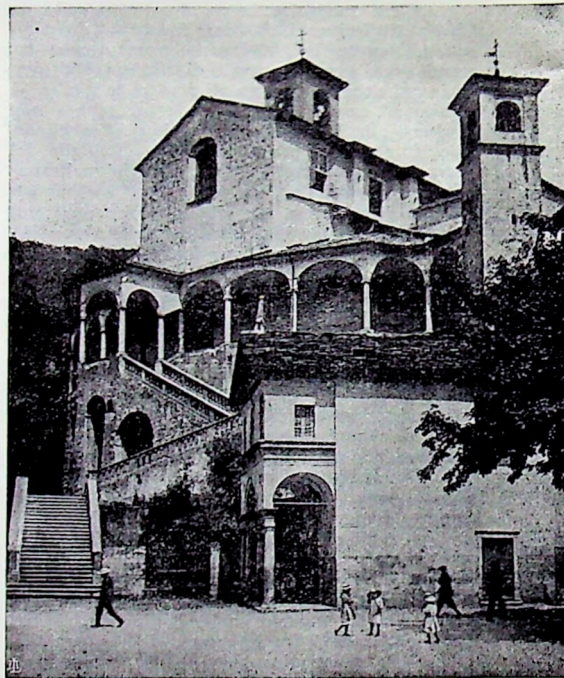
...la vecchia Chiesa di S. Marta, che sorgeva in piazza Vittorio, sotto la Collegiata, è stata demolita molti anni orsono...
