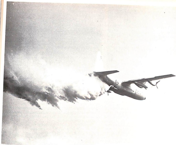
4) L'aereo Lockheed C-130 col MAFFS in azione. Il lancio viene effettuato di norma a velocità di circa 200 km/h e a quote variabili fra i 30 e i 100 metri.
