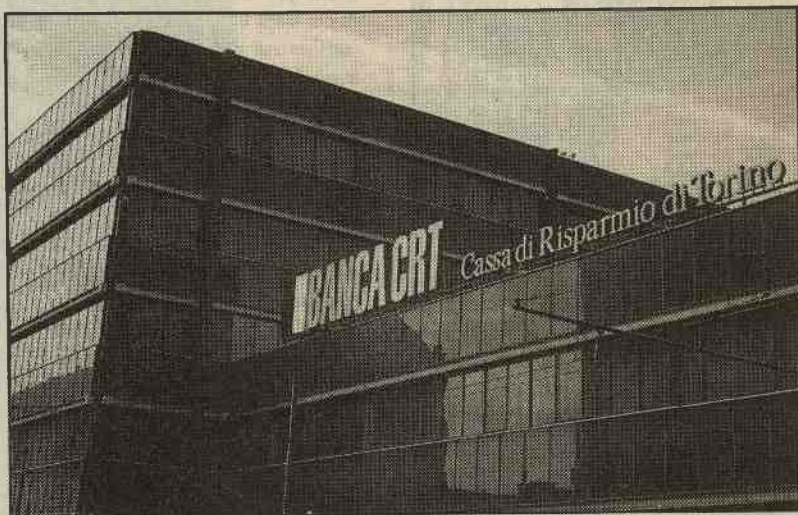
Palazzo uffici BANCA CRT - Torino
