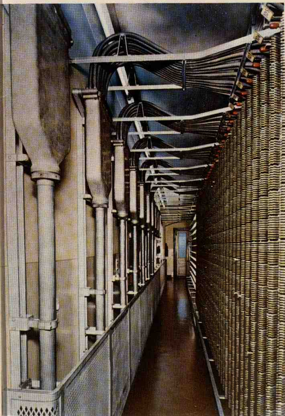
In alto: Sala dei selettori della centrale automatica «Ognina» di Catania
