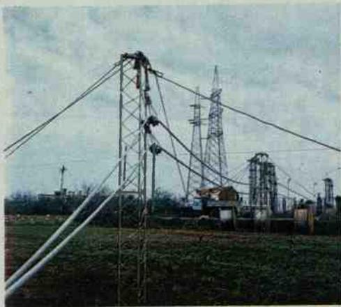
*Il difficile lavoro di tesatura dei conduttori e il montaggio di tralicci di una linea da 220 kV: sostegno per sostegno, campata per campata si predispone la linea per il trasporto dell'energia.*
